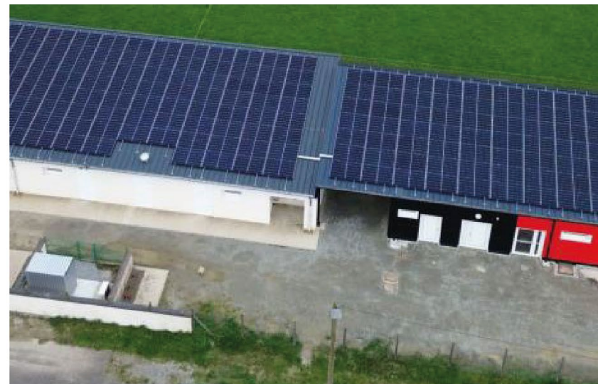
Installation PV d'Energ'iV
