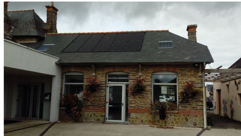
Installation PV de la commune
