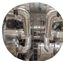
RÉCUPÉRATION DE CHALEUR FATALE
