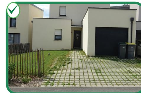
**Pavés béton à joints engazonnés**
